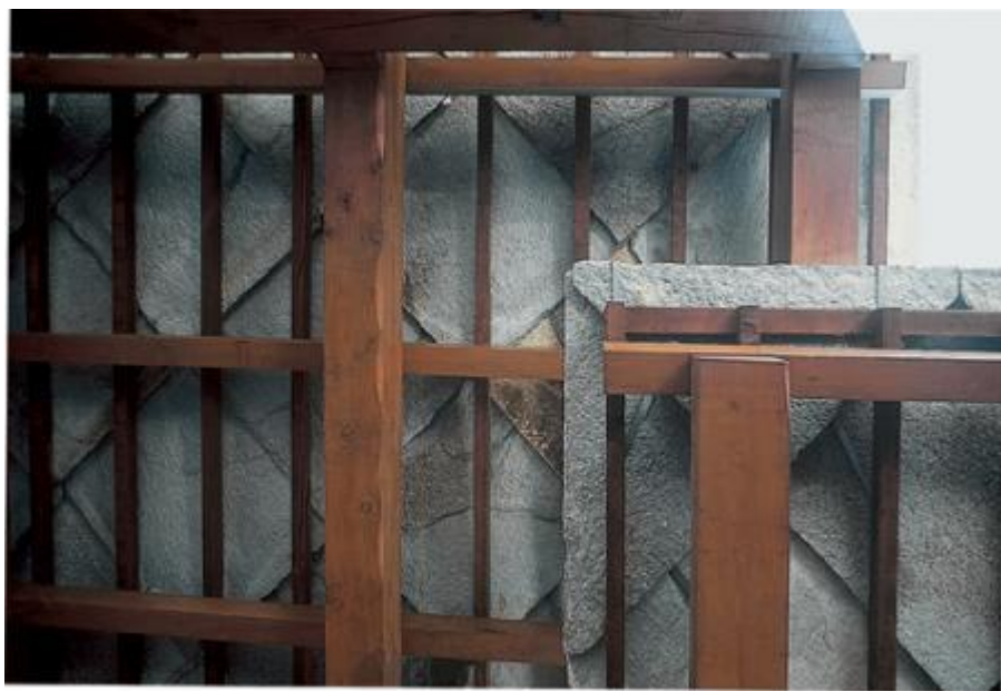
Scorcio della copertura
