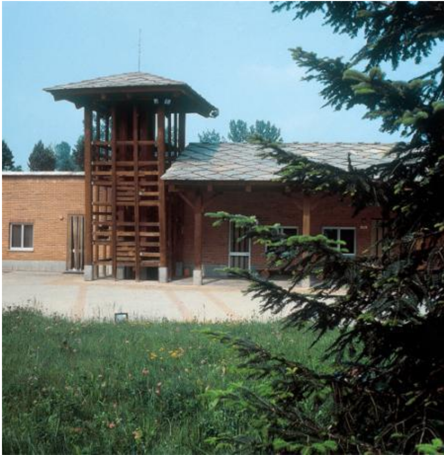
Il pilastro del portico con capitello a puntoni
