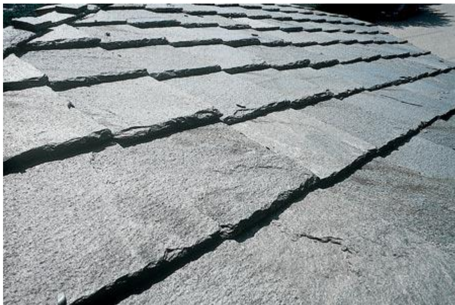
Dettaglio del manto in lastre litiche
