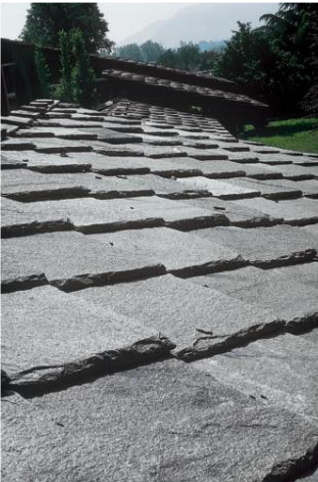
L'intradosso del manto di tenuta in lastre litiche
